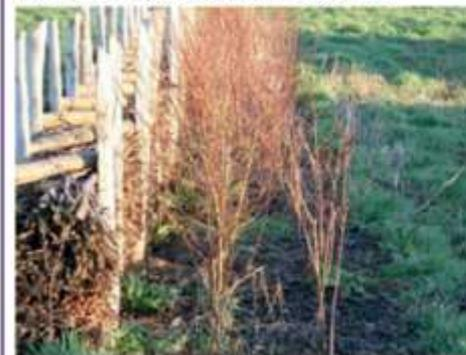
La fascine est un aménagement linéaire constitué de branchages. Positionnée en travers du ruissellement, elle constitue un obstacle perméable qui freine l'eau.
