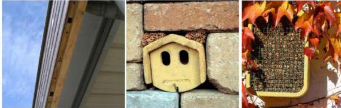
1.- Gîte à chauves-souris inclus dans un rebord de toiture sur un bâtiment neuf / 2.- Gîte inclus dans un mur de pierre / 3.- Structure de tiges creuses installée sur un mur végétalisé de vigne vierge.
