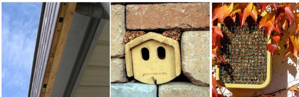
1.- Gîte à chauves-souris inclus dans un rebord de toiture sur un bâtiment neuf / 2.- Gîte inclus dans un mur de pierre / 3.- Structure de tiges creuses installée sur un mur végétalisé de vigne vierge.
