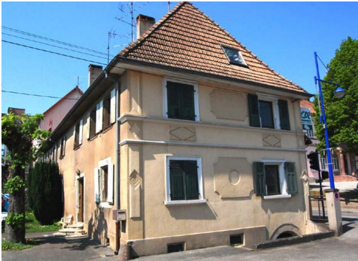
Figure 7. Pignon est et façade sud
