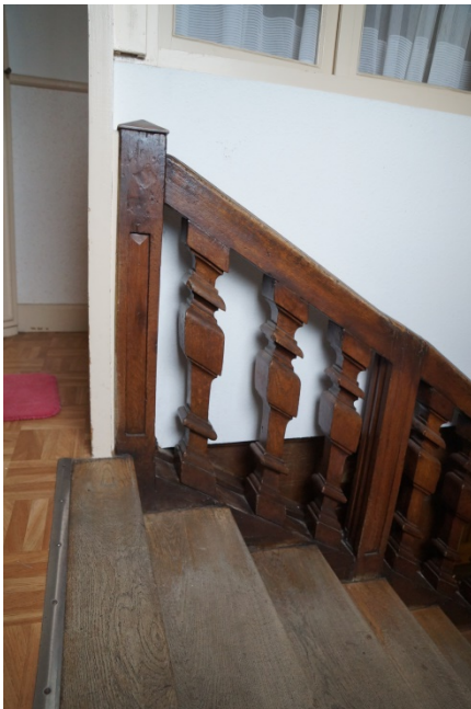
Figure 12. Détail du garde-corps de l'escalier monumental
