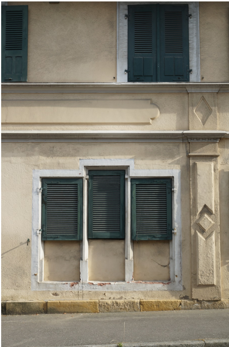
Figure 9. Fenêtre en triplet de l'échoppe sur la façade nord et détail d'un pilastre
