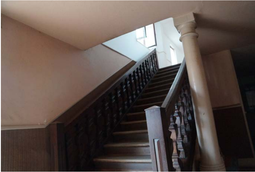
Figure 11. Escalier monumental et colonne sur laquelle repose la sous-poutre de trémie
