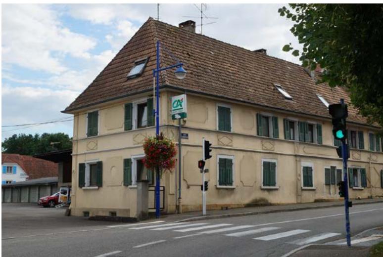
Figure 8. Pignon est et façade nord
