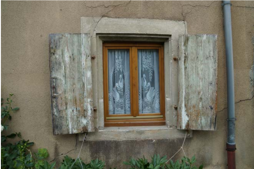
Figure 2. Exemple d'encadrement de fenêtre d'origine
