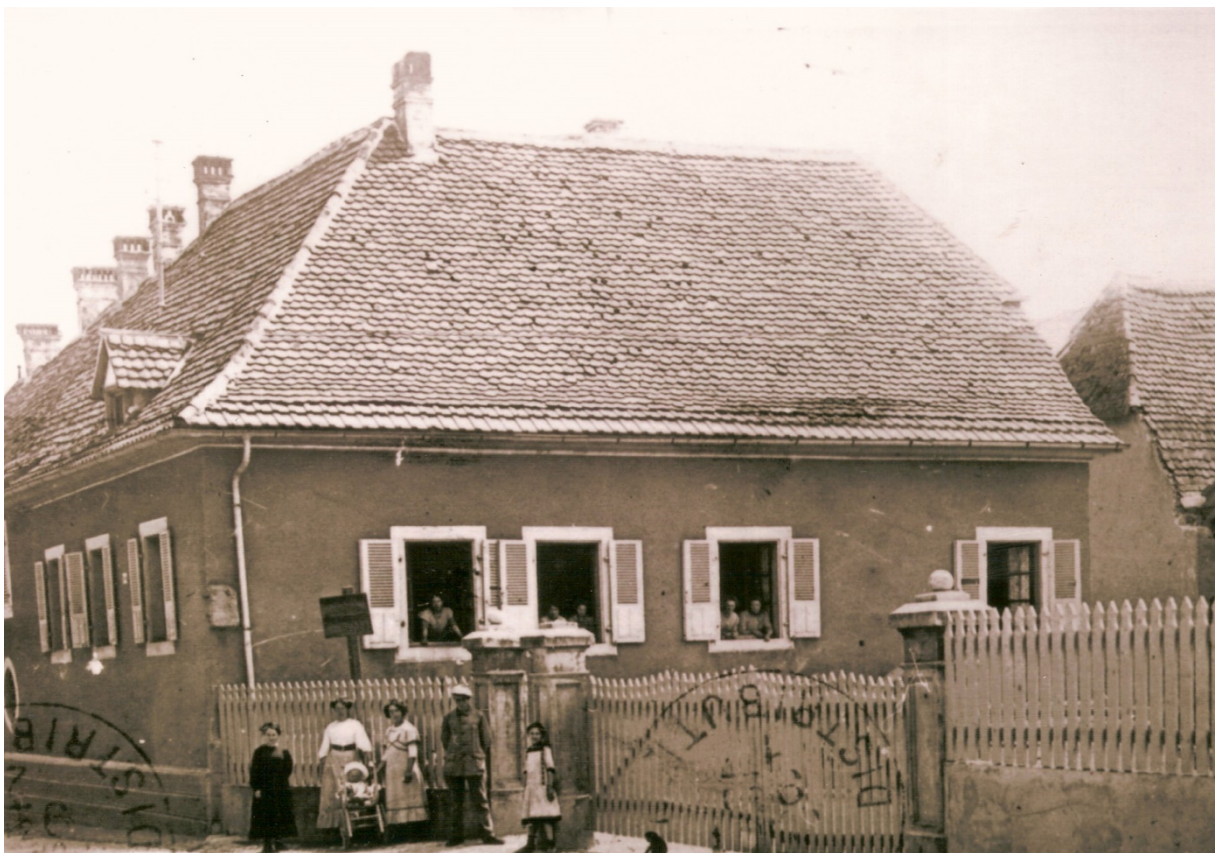
Figure 16. Maison du receveur (démolie), façades nord et ouest. On distingue à gauche une partie de l'oculus qui éclairait le préau entre cette maison et la maison seigneuriale .
