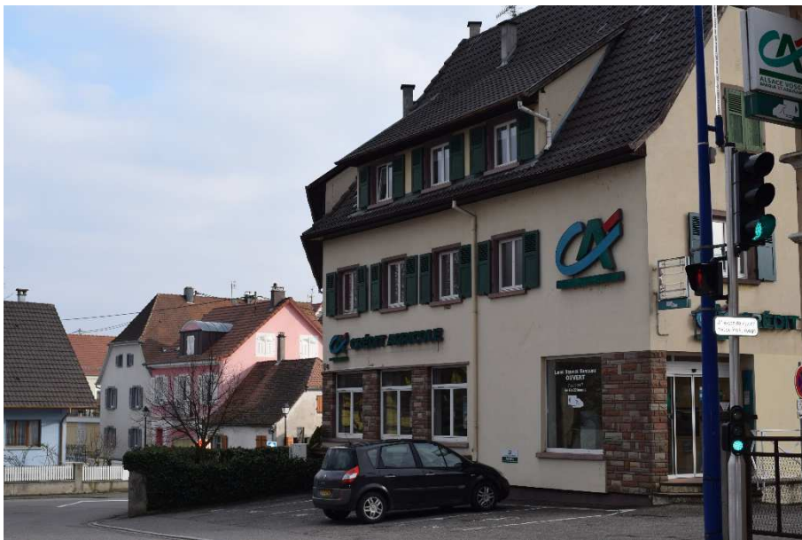
Construction n°2 datant des années 1960 : agence du Crédit agricole au rez-de-chaussée et 8 logements aux premier et second étages. En bon état et dans l'esprit du lieu.
