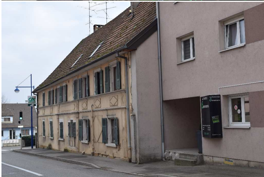
Le « château Waldner » a été dévalorisé dans les années 1980 par la construction d'un bâtiment sans âme
