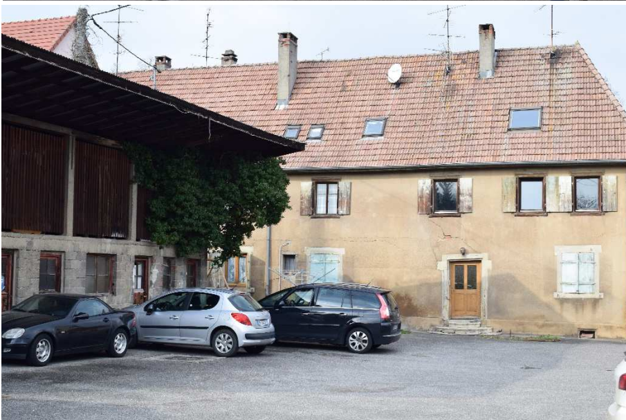
Construction n°3 perpendiculaire au « château Waldner » : ateliers et local de stockage.
