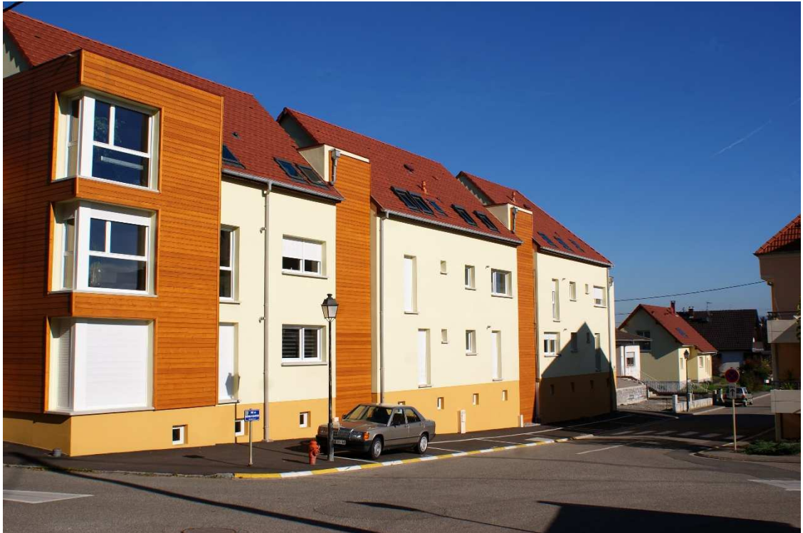
Exemple (parmi d'autres) de construction récente à Bartenheim, répondant aux différentes suggestions pour assurer une bonne insertion dans un centre ancien.
