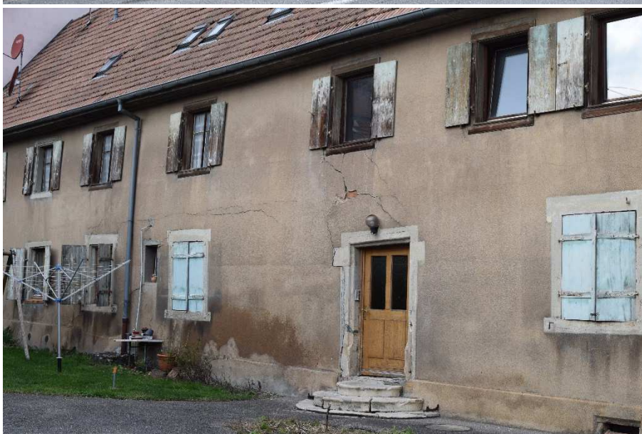
Façade arrière du « château Waldner » : en mauvais état, parcourue par des fissures.
