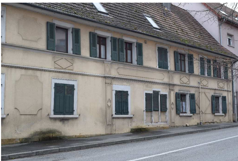
Façade du « château Waldner » donnant sur la route : non entretenue, elle est affectée par l'humidité.
