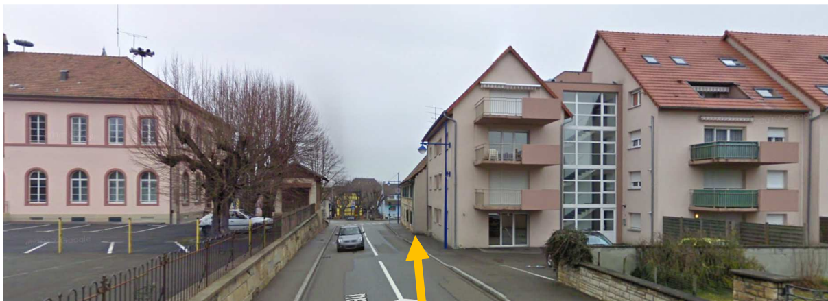
L'entrée Ouest dans la ville et la position de la maison Waldner
