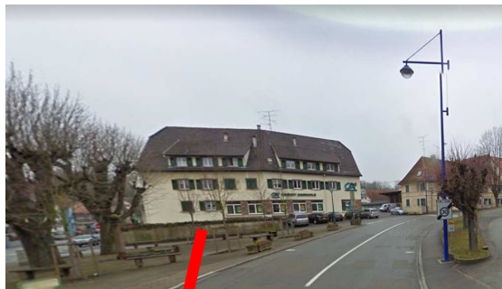
L'immeuble de logements + agence bancaire
