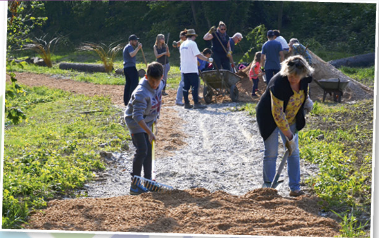
Mise en place de concassé sur le chemin piéton du parc du Domaine Haas
