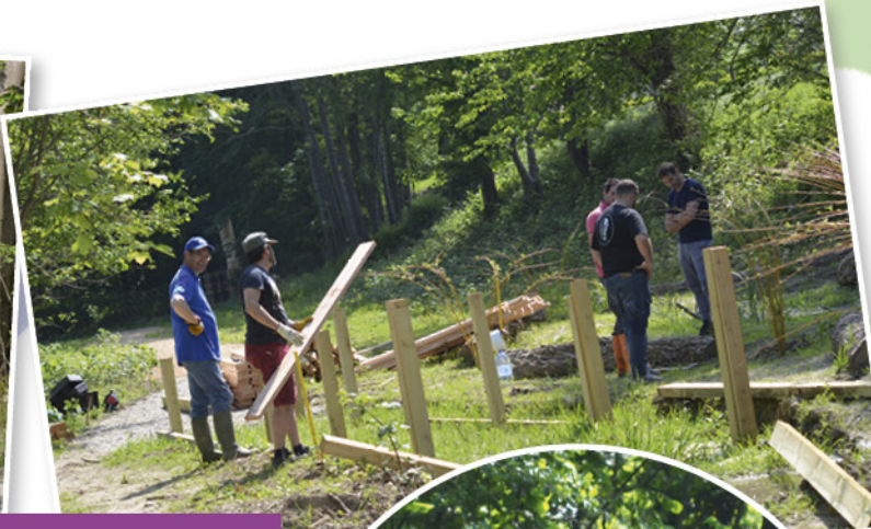
Réalisation d'un platelage bois dans le parc du Domaine Haas
